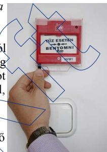
15.ábra: Kézi jeladó ellenőrzése
